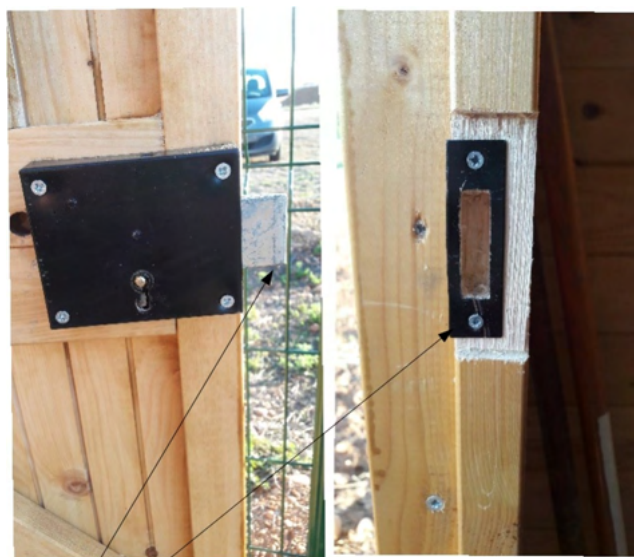
La pêne de la serrure n'est pas forcément en face de la gâche.
